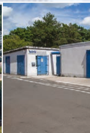
Produktionsstätte Hoyerswerda Production site Hoyerswerda
